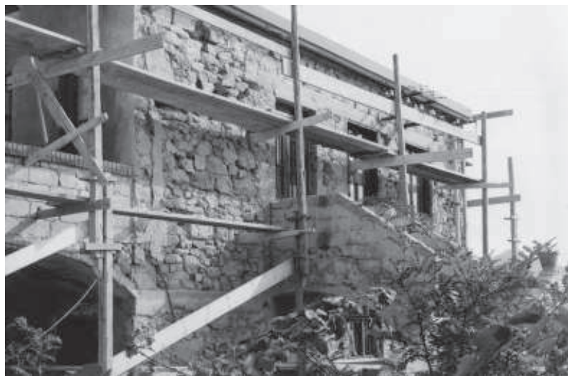
39_ La fotografia del cantiere mostra la natura profondamente muraria ed il legame con le tecnologie costruttive tradizionali della edilizia autarchica (Archivio IACP, Carbonia). 40_ 41_ 42_ Le voltine laterizie sottili del tipo "Santi ridotto". Il sistema degli orizzontamenti intermedi in muratura, proprio di tutte e 7 le tipologie abitative della prima fase di edificazione di Carbonia, consente di ridurre al minimo l'uso del ferro, limitato agli architravi ed ai cordoli dei muri che sostengono le volte (Archivio IACP, Carbonia).
